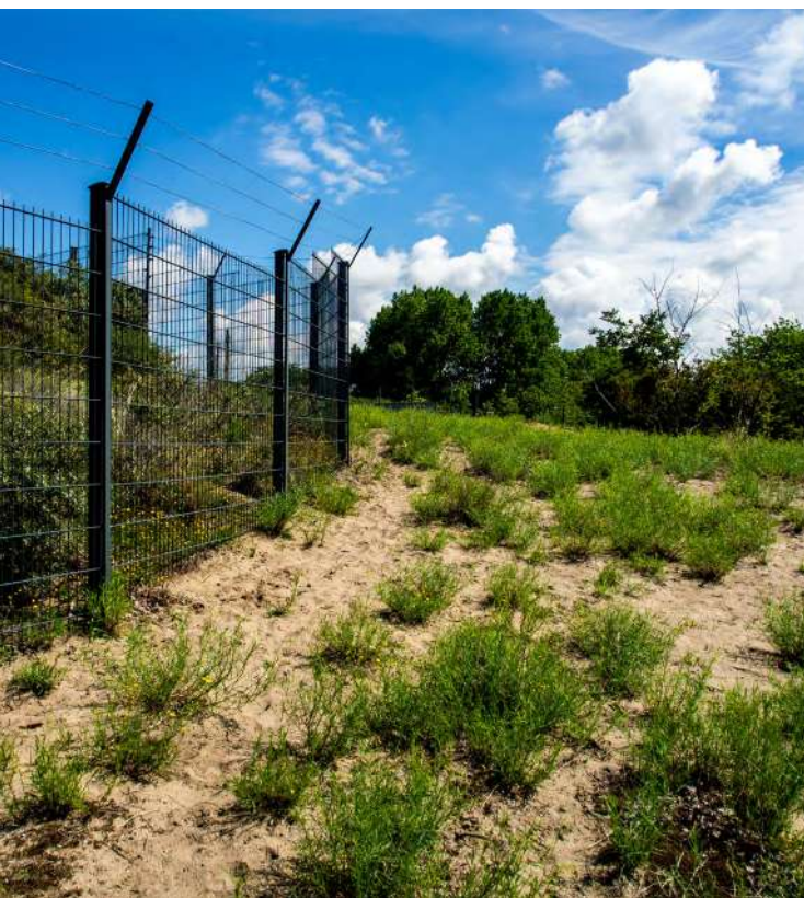
Damhertkerend hekwerk AWD
