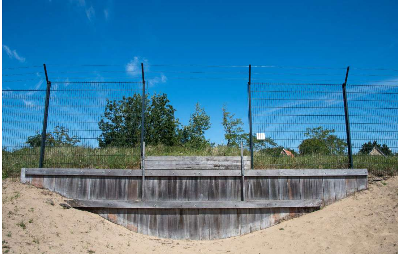
Inspringopening in het damhertkerend hek. Damherten kunnen van buiten het hek wel de AWD in springen, maar ze kunnen niet de AWD uit springen.
